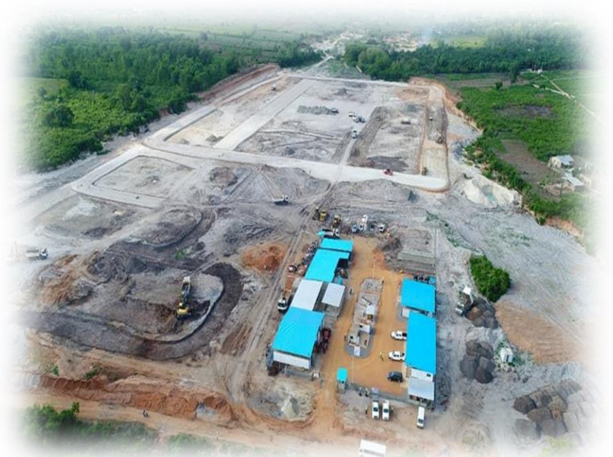
©Le site de construction d'une station de traitement des boues fécales à Kansoukpa, dans la commune d'Abomey-Calavi.
